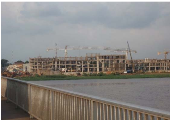
Le nouveau siège de l'Assemblée Nationale en construction (vu du Pont).
