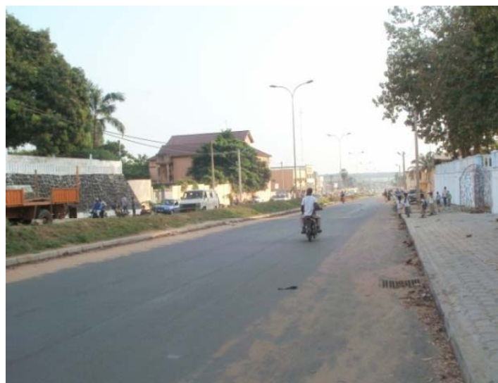
En entrée de ville, la voie reliant le pont sur la lagune à la place Bayol vient d'être entièrement refaite.
