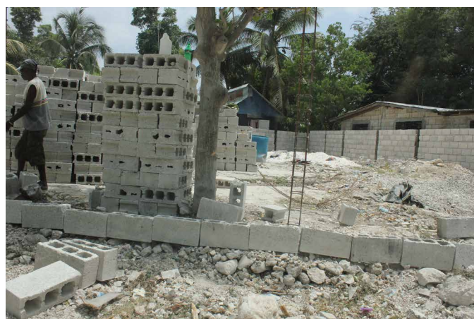
mise en place d'une clôture autour d'une maison en chantier
