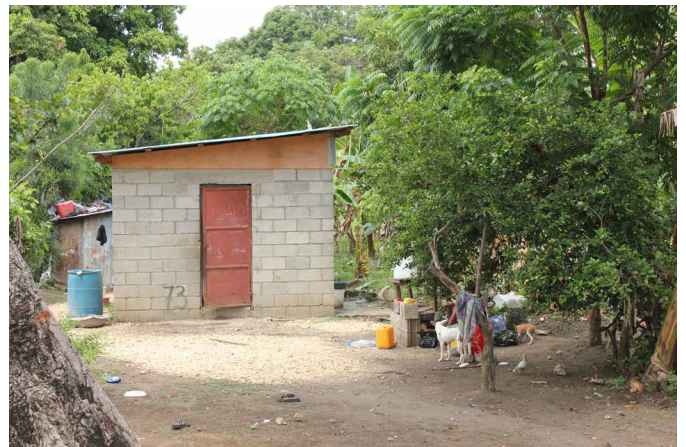
construction en parpaings, zone d'extension, Léogâne
