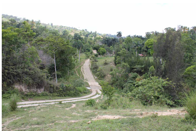
section partiellement bétonnée partiel d'une route dans les mornes. Andero, Petit-Goave
