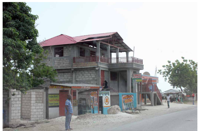
une grosse construction le long de la RN2
