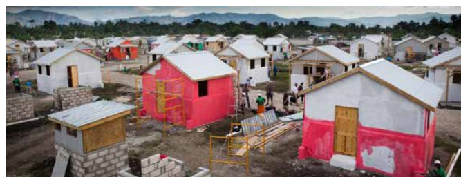
Habitat pour l'Humanité, Carter Work Project, février 2012. 155 familles sont relocalisées dans des maisons en béton et bois. Léogâne, communauté Santo.
