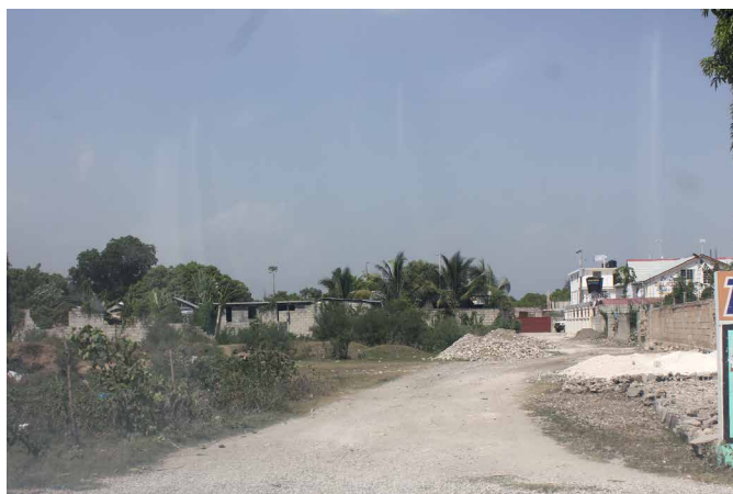
Constructions informelles dans la zone de Chatuley, Léogâne
