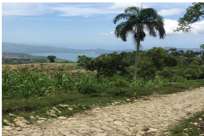
ouvrage pavé sur la route d'Andero, Petit-Goave
