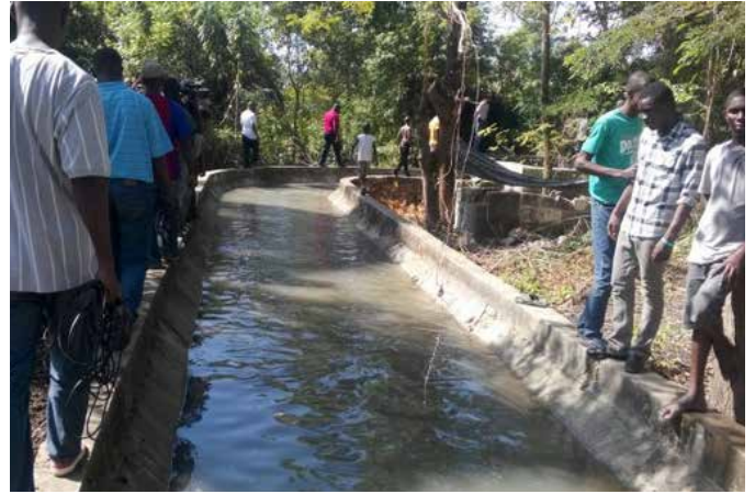
canal du système d'irrigation 2 ème section, Petit-Goâve
